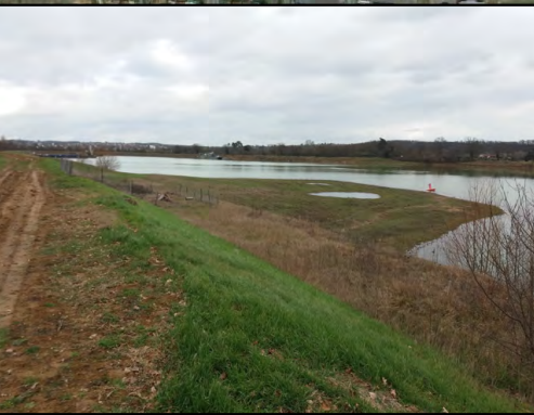
Prairie inondable réalisée en 2016
