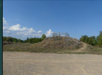
Belvédère réalisé en 2016
